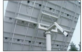
Der Linearantrieb »LD60« mit korrosionsgeschütztem Alugehäuse und -schubrohr, ebenfalls mit integrierten Lastenschaltern und Sensorik, dient zusammen mit den Lagerböcken BB1 zur sicheren Bewegung der Solarfläche in vertikaler Richtung.
